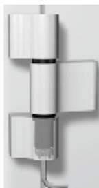
» Mit Verstellstern untere Lagerbuchse um  $\pm 90^\circ$  drehen bis sie spürbar einrastet.
